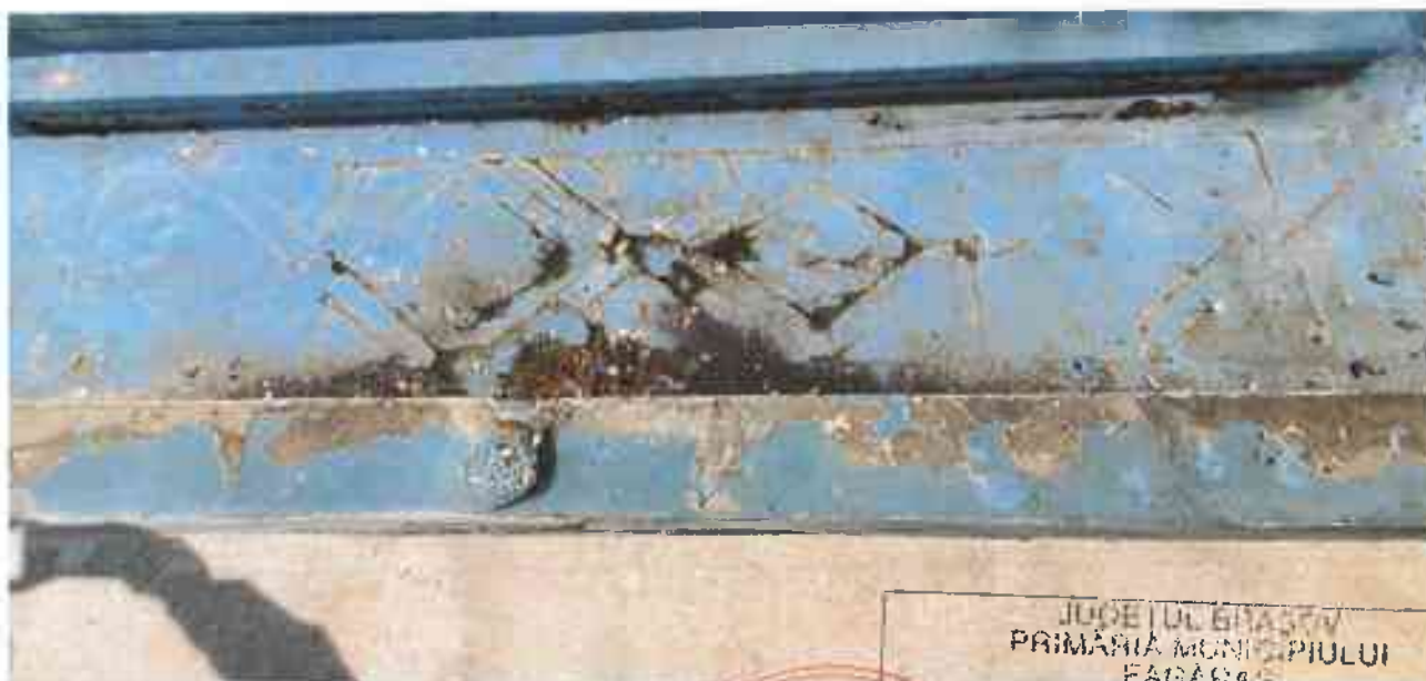
Foto 13 – Detaliu degradări desen de pardoseală
