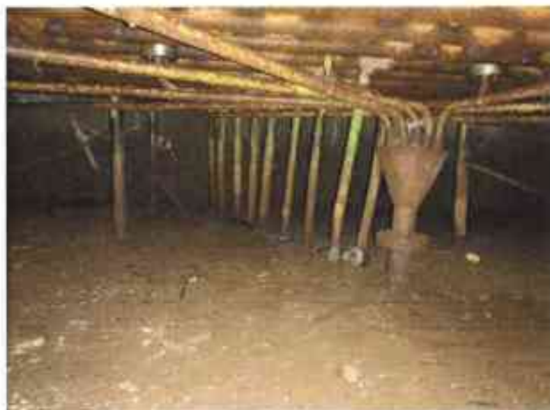
Foto: Degradări la nivelul instalațiilor aferente
