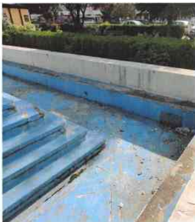
Foto 11.1, 11.2 – Detaliu degradări alimentare bazin
