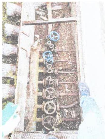
Foto: Degradări la nivelul instalațiilor aferente
