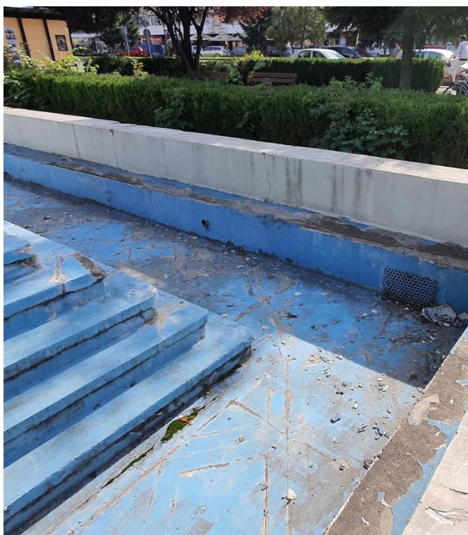
Foto 11.1, 11.2 – Detaliu degradări alimentare bazin
