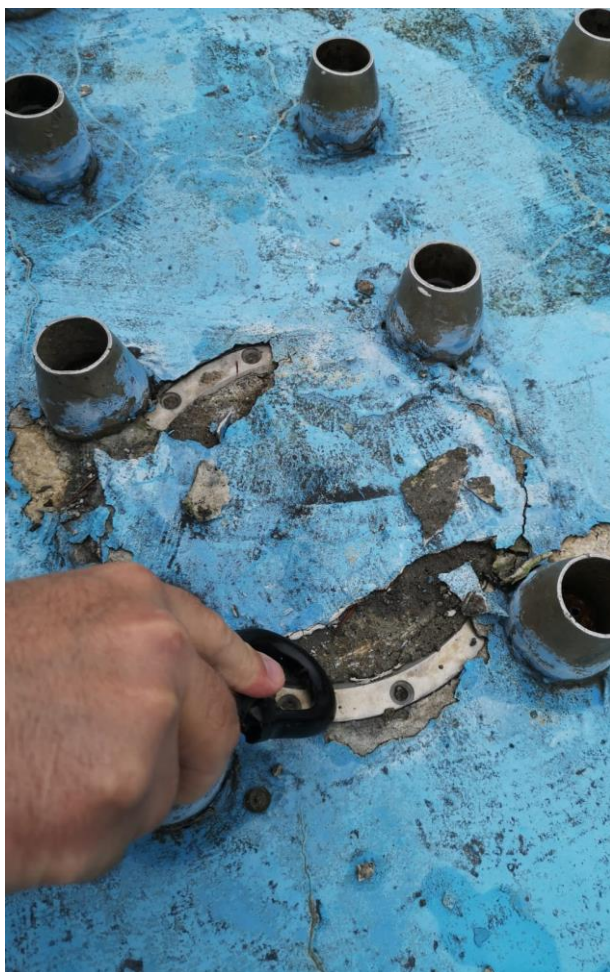
Foto 10.1, 10.2 – Detaliu degradări lumini arhitecturale
