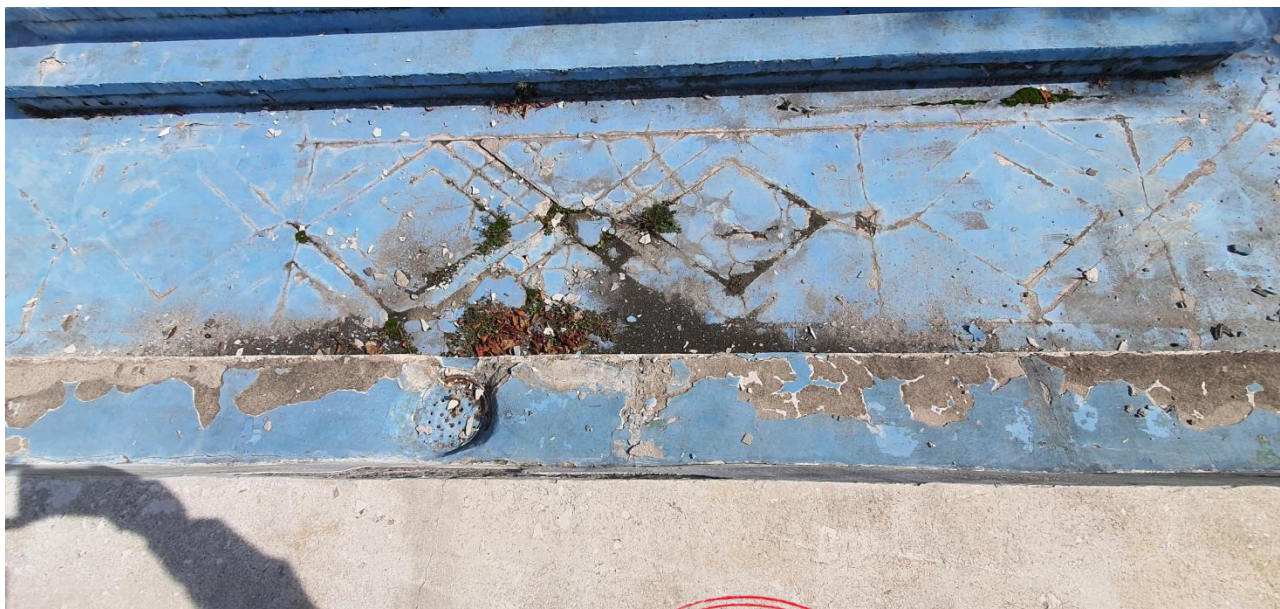
Foto 13 – Detaliu degradări desen de pardoseală
