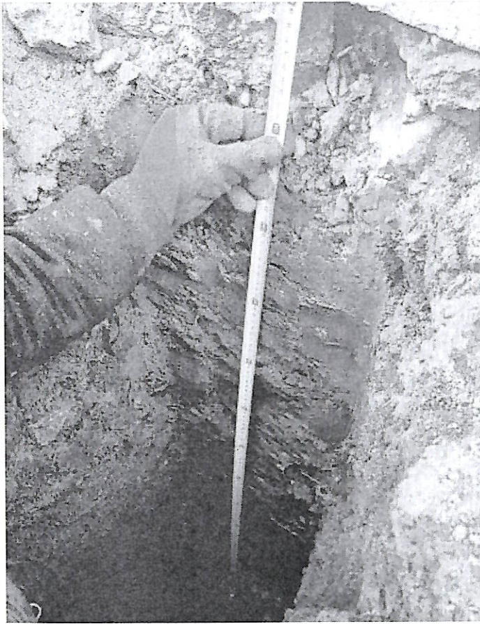
Fig. 9 Dezvelire de fundație realizată la adâncimea de D_f = 1,40 m
