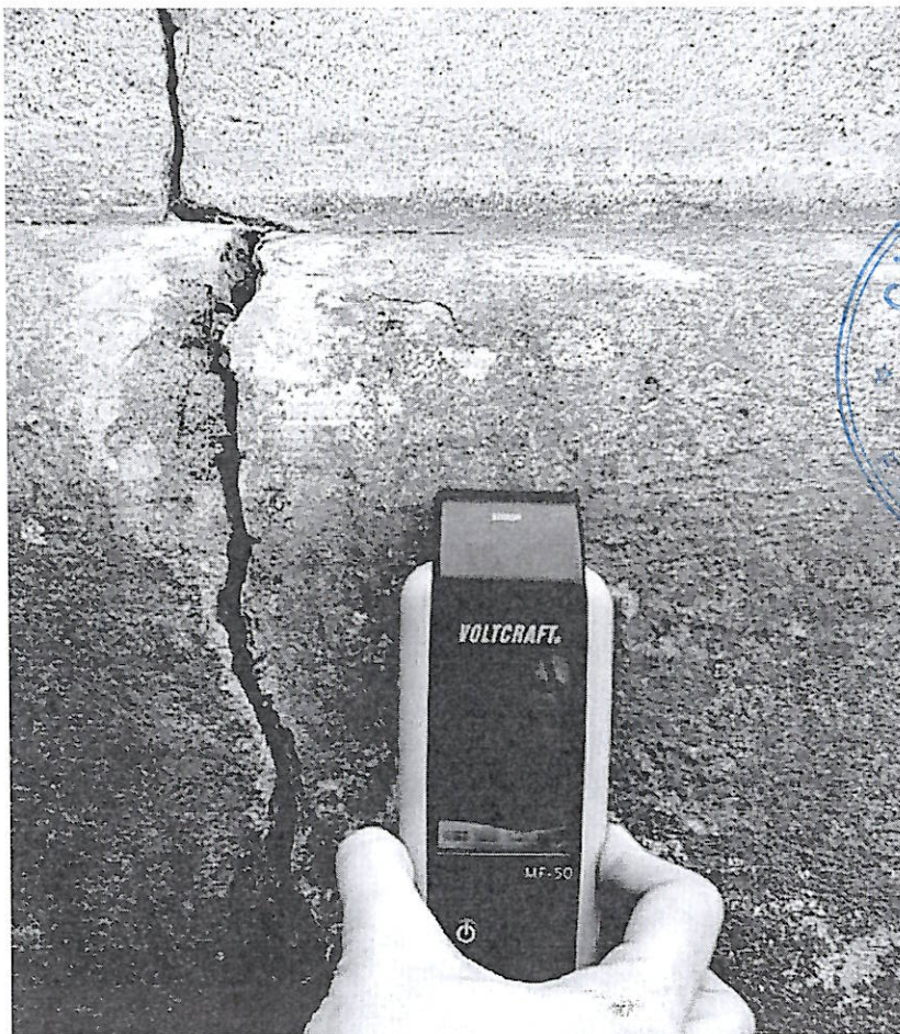
▲Degradări semnificative apărute la soclul imobilului
