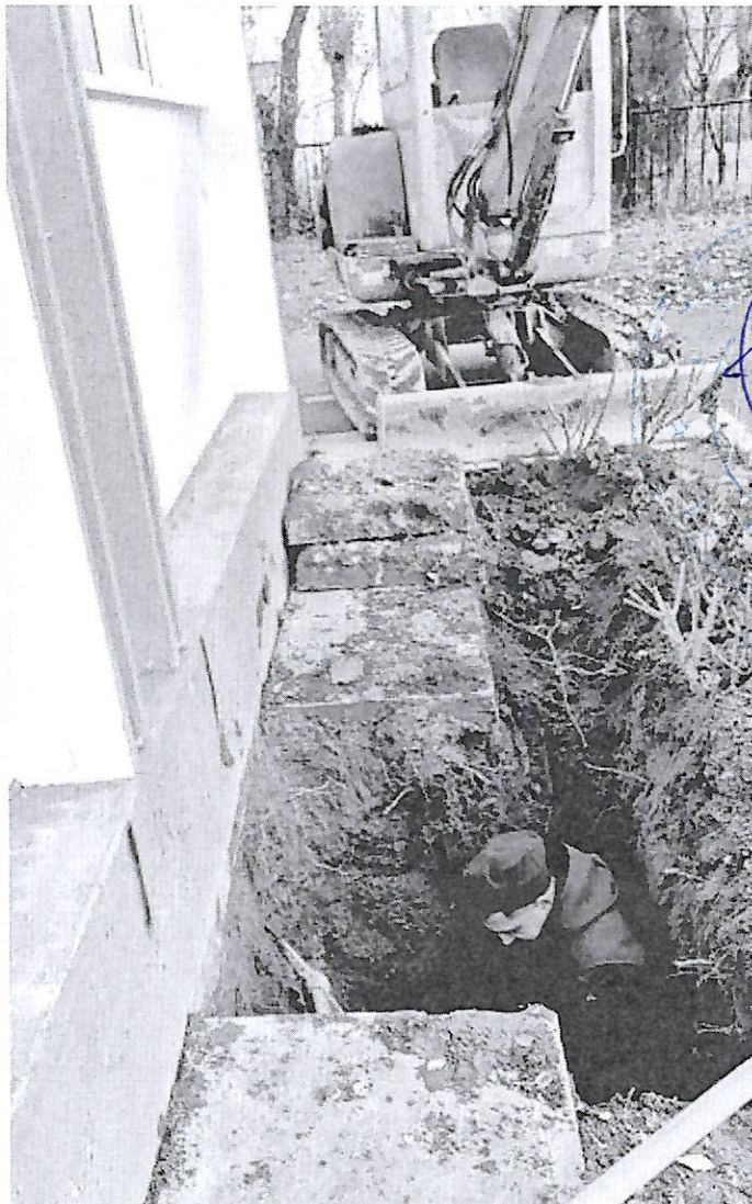
Fig. 9 Dezvelire de fundație realizată la adâncimea de D_f = 1,10 m
