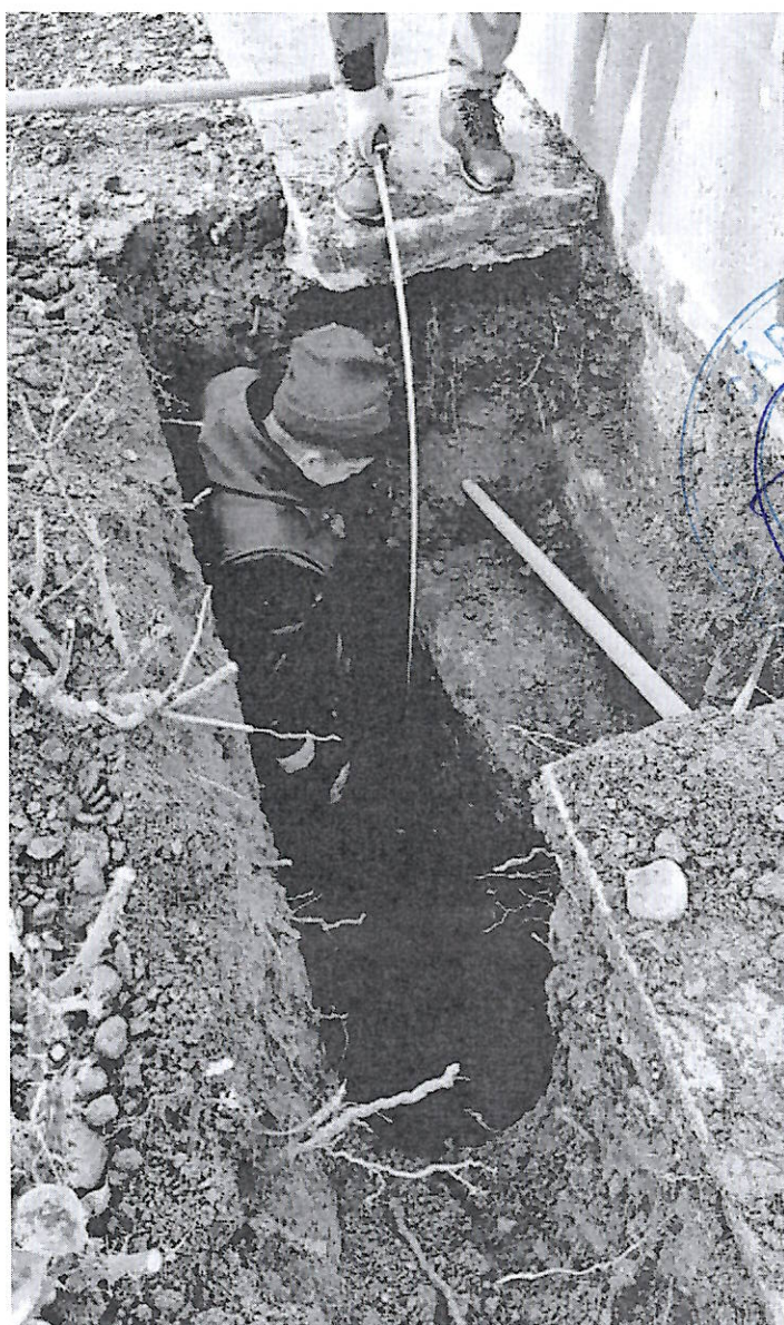
Fig. 11 Dezvelire de fundație realizată la adâncimea de D_f = 1,10 m
