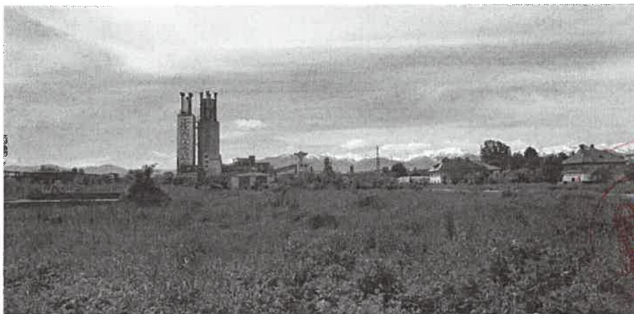
FIGURA 10 PLATFORMA NITRAMONIA (VEDERE DE LA DRUMUL JUDEȚEAN DJ104B), MUNICIPIUL FĂGĂRAȘ, 2022
