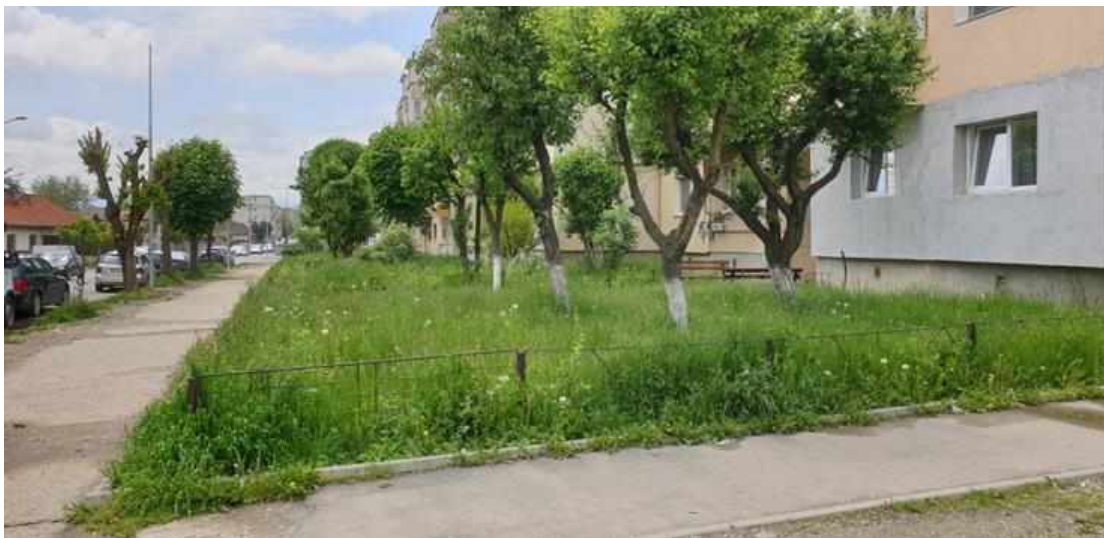
FIGURA 21 TROTUAR CU SPAȚIU VERDE LINIAR PE STRADA 1 DECEMBRIE 1918 DIN MUNICIPIUL FĂGĂRAȘ, 2022
