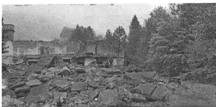
Dărâmătura de la Banská Bystrica, Slovacia
