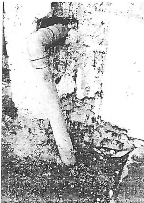
Conduite de canalizare scoase din exterior prin peretele de rezistență Instrucțiunile conducute originale ale Blocului 10-au rămas tot pendentă, a fost vătărat.
